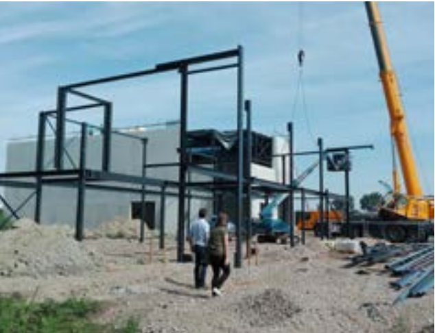
Beeuwsaert Construct aan het werk.
